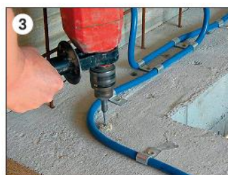
układanie i mocowanie węża
