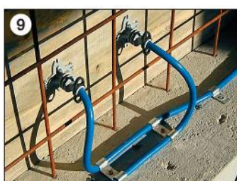
widok ułożonego na gotowo węża do iniekcji WATERPROOF X®1
