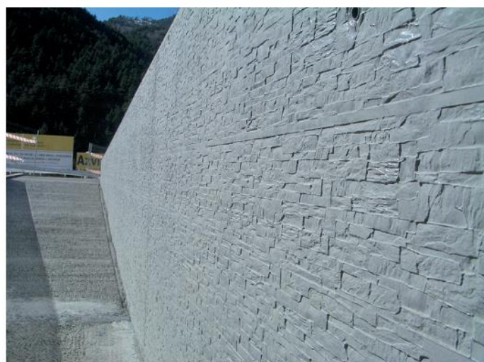
betonowa ścianka oporowa o strukturze kamienia.
