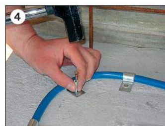
wąż WATERPROOF X®1 należy układać na płasko
