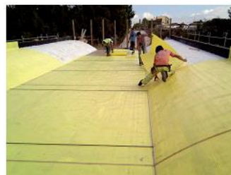
układanie mat strukturalnych
