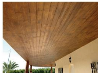
przykład pomalowanej struktury drewnianej
