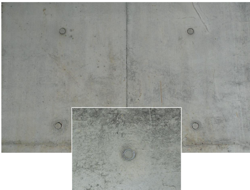
nakładanie kleju w otworze stożkowym
