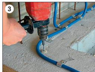
3 układanie i mocowanie węża
