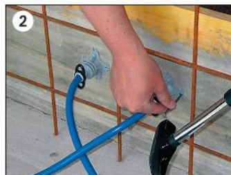
2 nakładanie pakunku na zbrojenie
