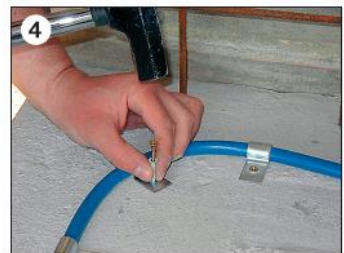
4 wąż WATERPROOF X®1 należy układać na płasko
