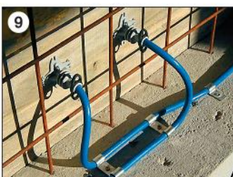
9 widok ułożonego na gotowo węża do iniekcji WATERPROOF X®1
